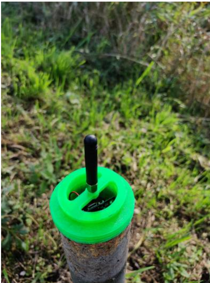
Fig. 4: Sensor und LoRa-Sender im Rohr installiert
