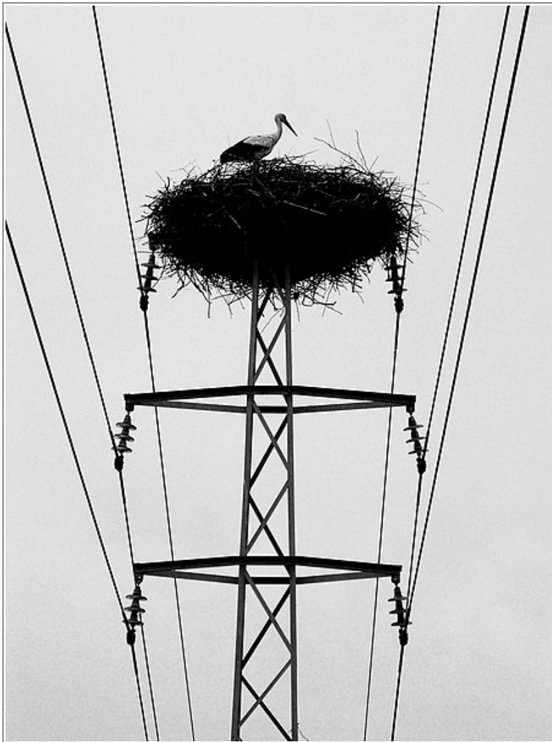
Storchennest auf einem Mast mit Mittelspannungsfreileitungen und der Gefahr eines Erdschlusses .
