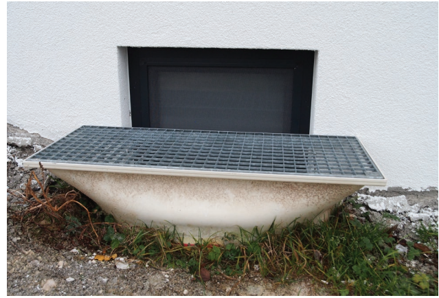
Abbildung 27: Kellerfenster ohne Überflutungsschutz (links); Kellerfenster mit erhöhtem Lichtschacht (rechts) (LUBW)
