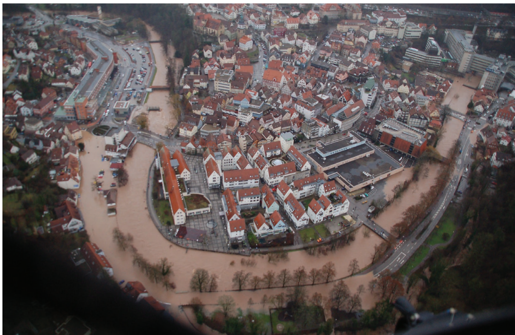
Abbildung 9: Hochwasser in Backnang 2011 durch Ausuferung der Murr (Polizeipräsidium Aalen)
